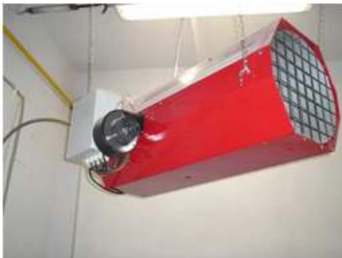
Рисунок 2.37 — Газовый теплогенератор-пушка
