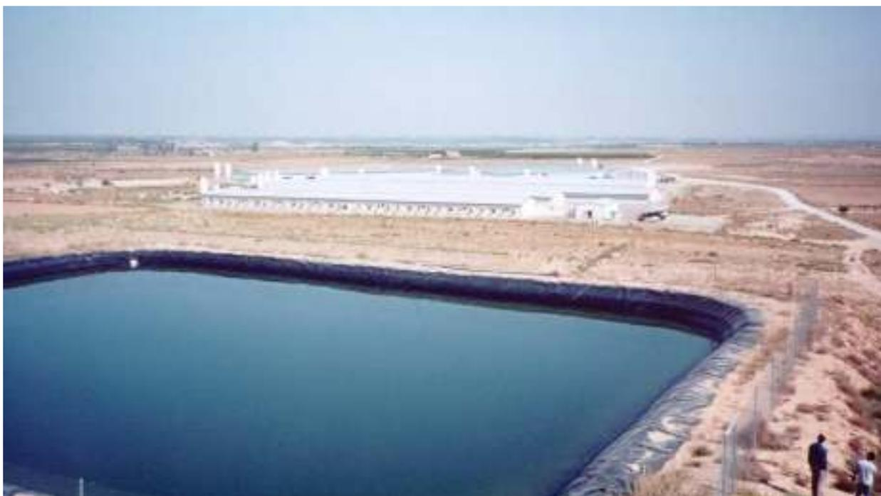
Рисунок 2.49 — Лагуна для сбора навозных стоков
