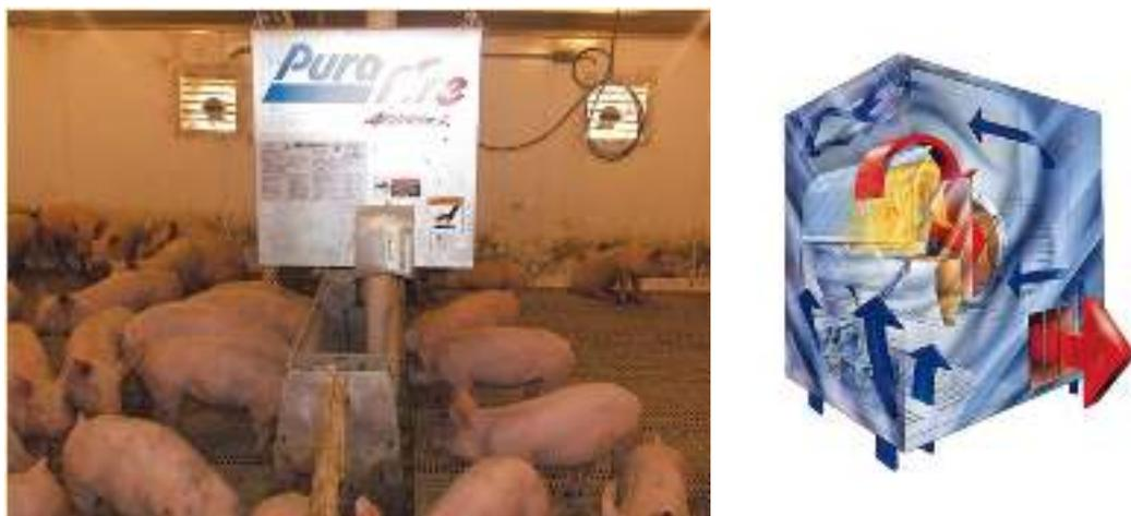
Рисунок 2.39 — Использование газовых теплогенераторов GSI в секторе поросят на доращивании
