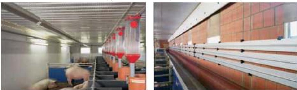
Рисунок 2.42 — Примеры установки дельта и твин-труб
