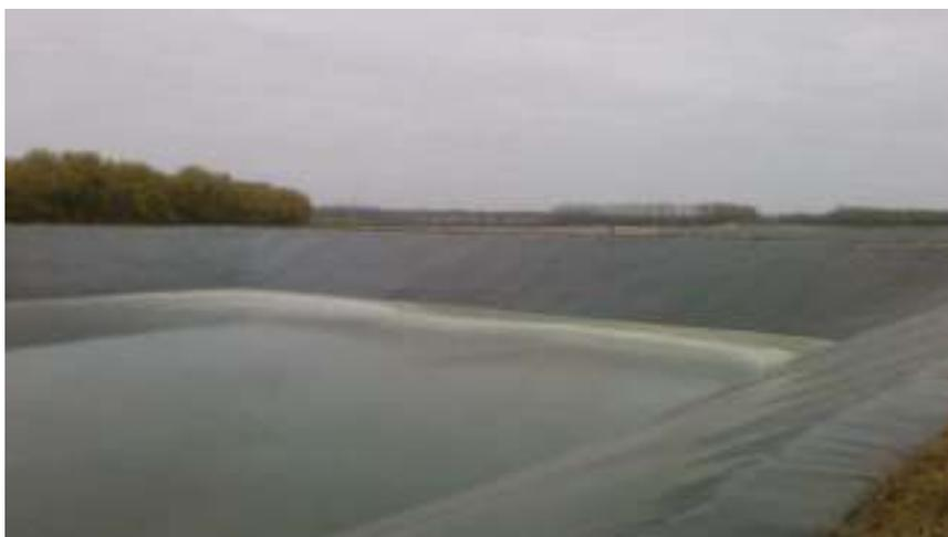
Рисунок 2.55 — Лагуна с пленочным покрытием только дна
