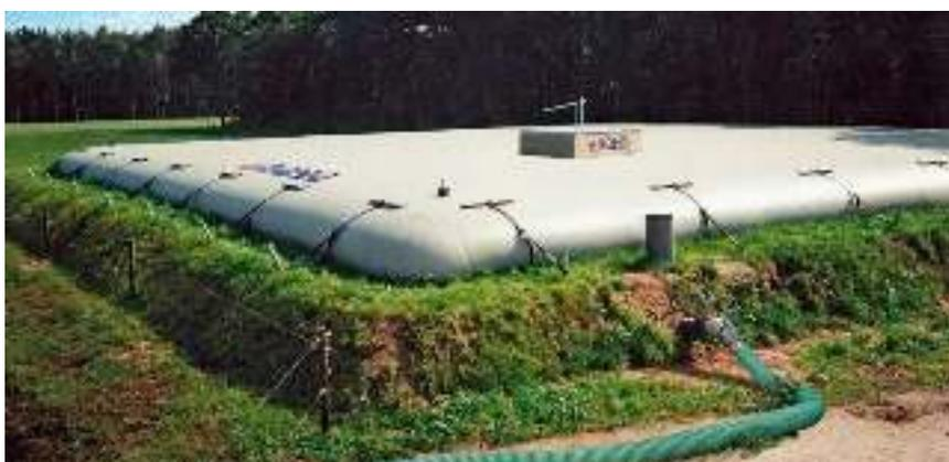
Рисунок 2.60 — Гибкий резервуар для хранения жидкого навоза
