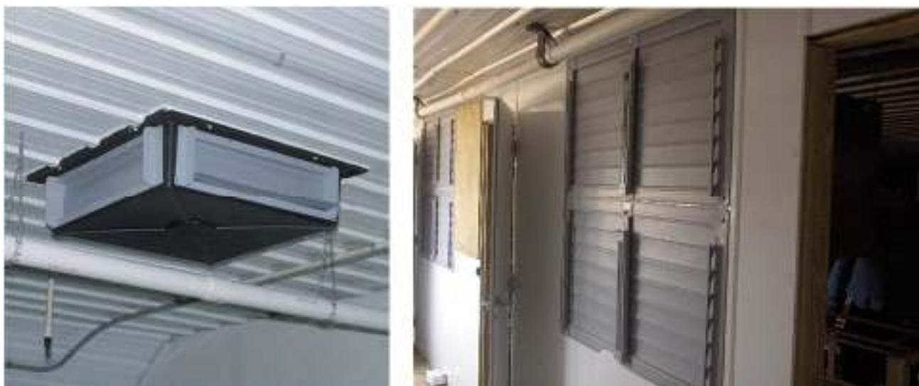
Рисунок 2.27 — Различные типы приточных воздушных клапанов
