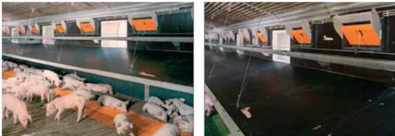
Рисунок 2.47 — Установка оребренных труб в секторе дорашивания
