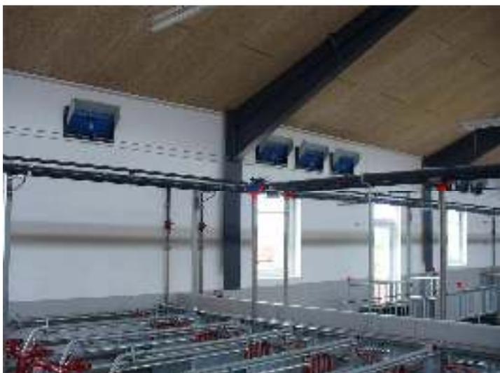
Рисунок 2.28 — Пример системы вентиляции с использованием приточных клапанов
