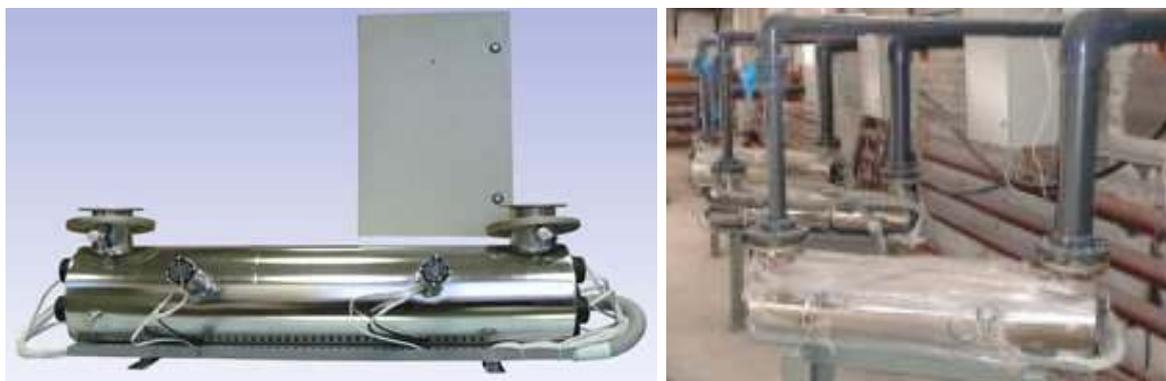
Рис.2.83 Блок УФ-обеззараживания
